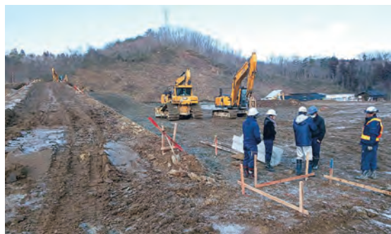
整備が進む平泉高田前工業団地第2次造成地区
