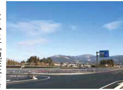
平泉スマートインターチェンジ
