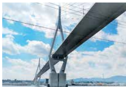
三陸自動車道「かなえ大橋」
