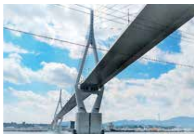
三陸自動車道「かなえ大橋」
