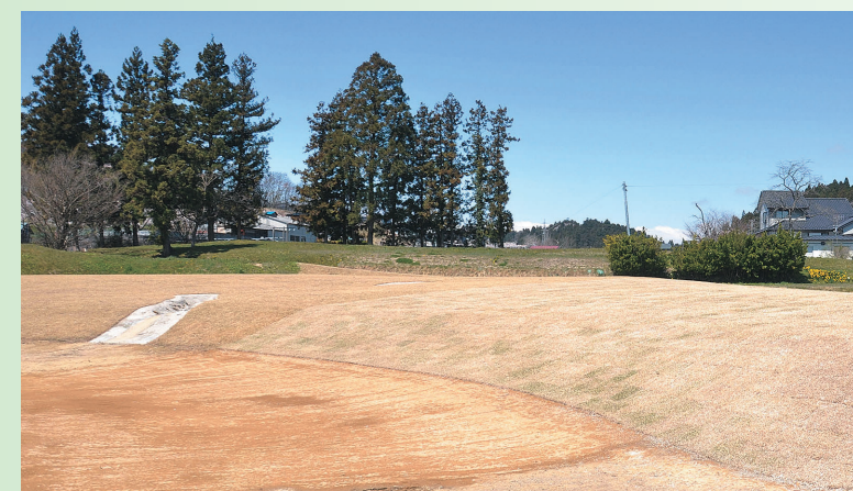
左/【写真2】 修復された池北側の岸(東から)
