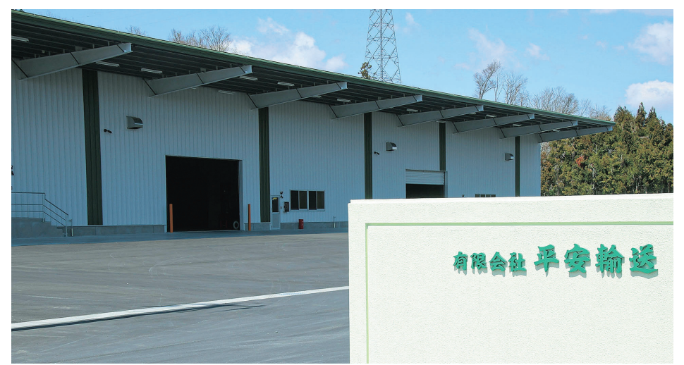
3月に完成した本社正面の貸し倉庫
