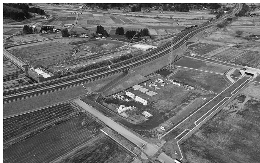
整備が進む平泉スマートインターチェンジ
