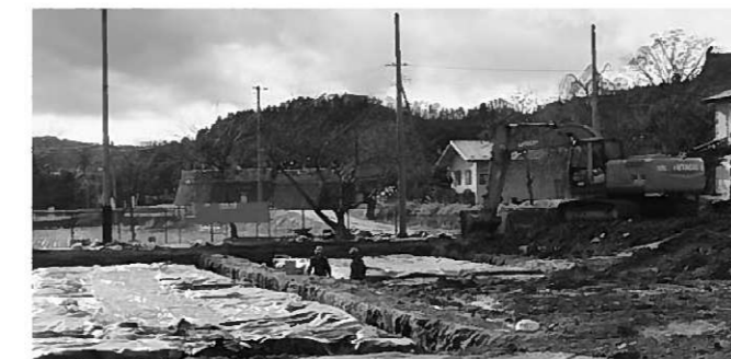
平泉中学校グラウンド除染作業の様子
