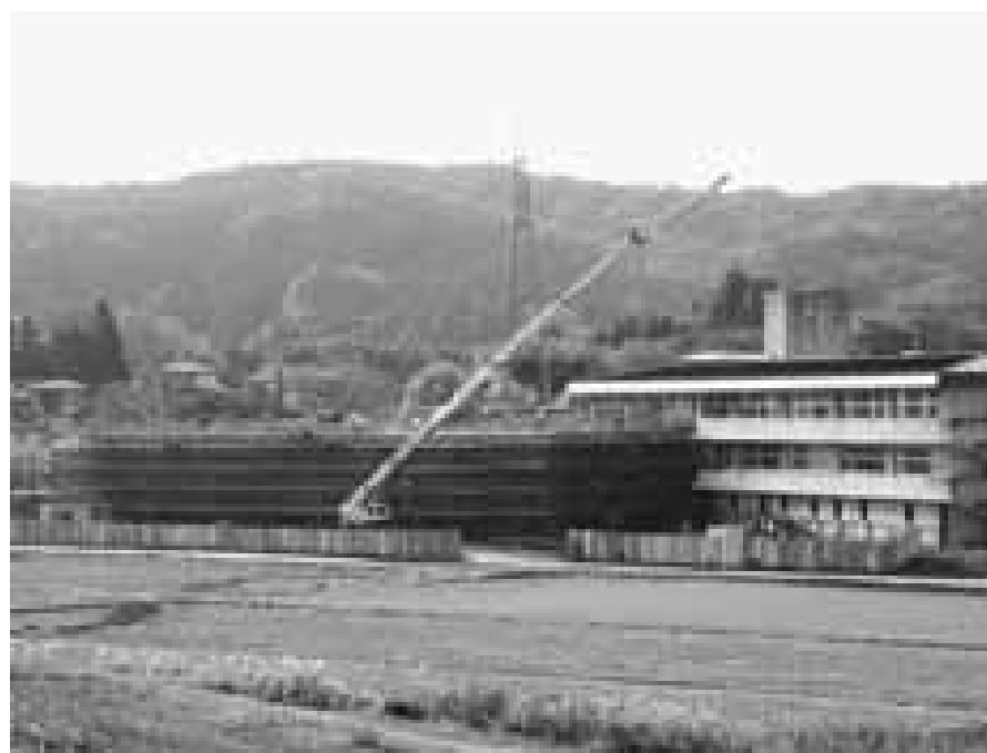
現在、既存校舎南側に建設中の新校舎南棟。2階部分の工事が行われており、徐々に新しい校舎の姿が見え始めました。(10月22日撮影)
