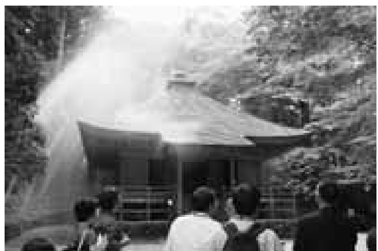
中尊寺経蔵では防火設備のドレンチャーによる放水を実演
