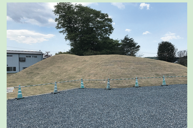
【写真2】修復された東土塁先端部(北から)
