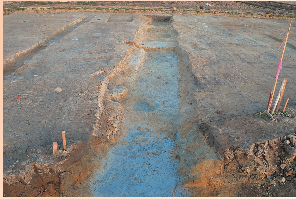
区画のために掘られた溝(西から) 調査区を東西に横断する溝で幅約2.5メートル、深さ約1メートルあります。底には段差がありました。
