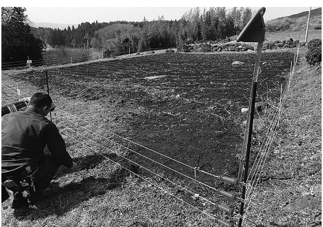
鳥獣被害防止のための電気柵設置
