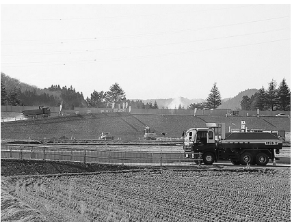
整備が進む平泉スマートインターチェンジ
