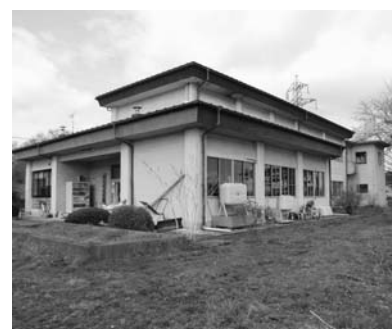
老朽化が進む町公民館
