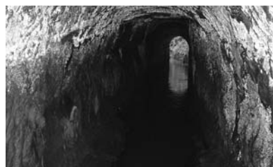
古くに開削されたトンネル内部
