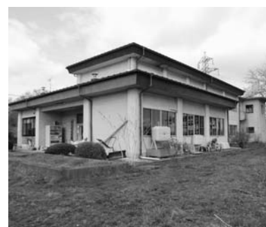
老朽化が進む町公民館
