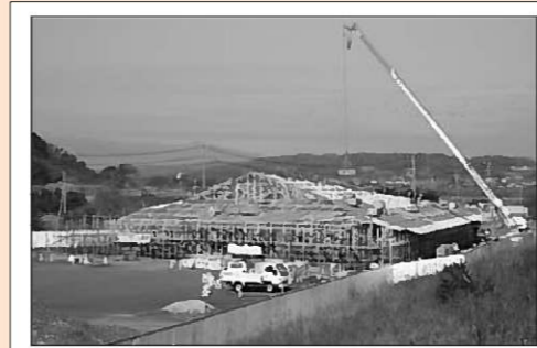
大型クレーンを使った屋根工事も進められた
