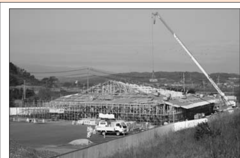
大型クレーンを使った屋根工事も進められた
