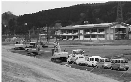
工事が進む町道中学校線
