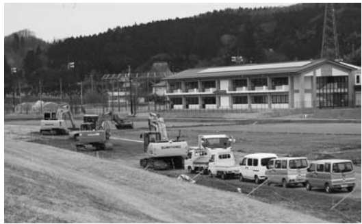
工事が進む町道中学校校線
