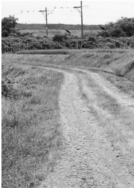
利用量が多くなり改修が望まれる町道三貫線
