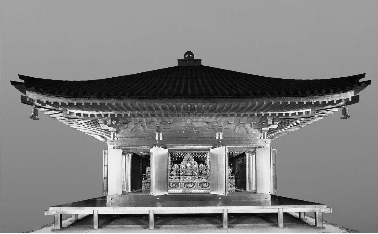
中尊寺金色堂。中尊寺は奥州藤原氏の初代清衡が12世紀始めから四半世紀をかけて造営した寺院。境内には金色堂、金色堂覆堂、経蔵などのなどの国宝や文化財がある。
