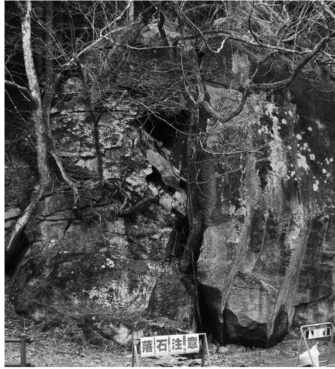
今回の大地震により、大きな亀裂が生じた髻石（5区）
