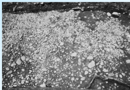
小さい石が敷き詰められた道路跡
