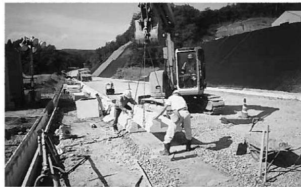
▲18年度に完成した町道鬮石線
