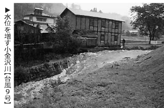
▶崩壊した水田のり面(台風9号)
