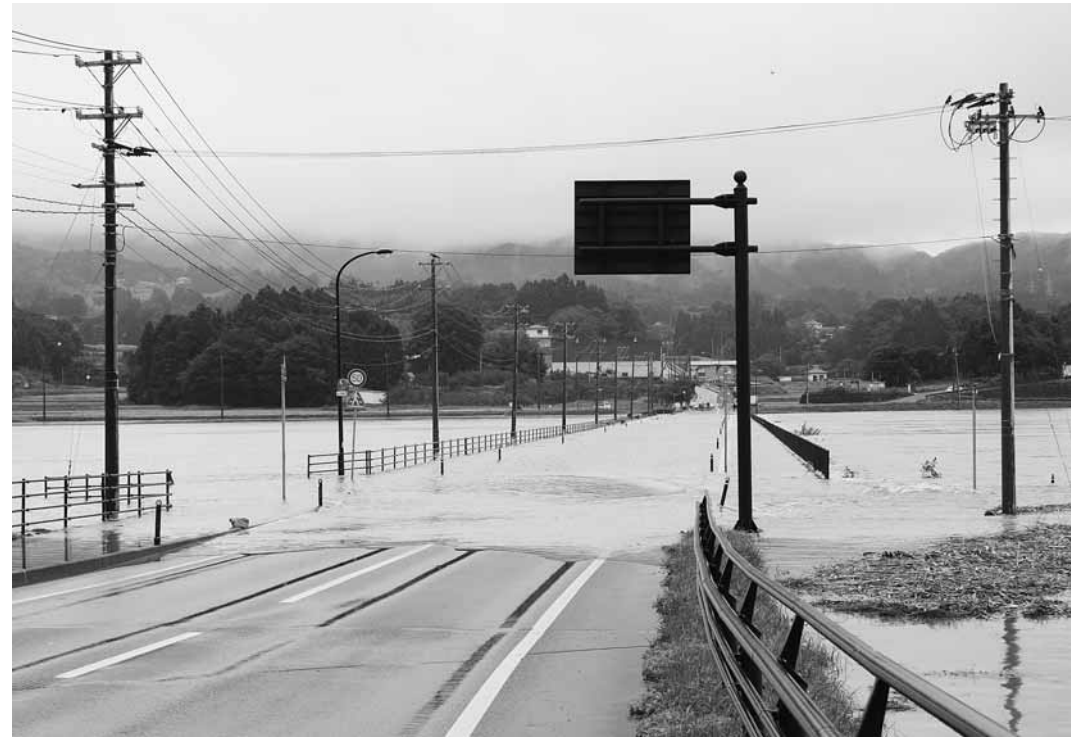
北上川の増水により冠水した県道相川・平泉線の高館橋 開田碑間【9月16日から18日にかけての豪雨】
