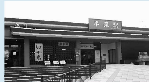
JR平泉駅舎（11区） 平安様式調のおやかな線を堅持しながら、新たな格子の設置と外壁等を茶色、黒に色上げすることによって、よりなじみやすい和風駅舎となっている。 ▷設計者＝株式会社ジェイアール東日本建築設計事務所（宮城県仙台市） ▷施工者＝仙建工業株式会社盛岡支店（盛岡市）
