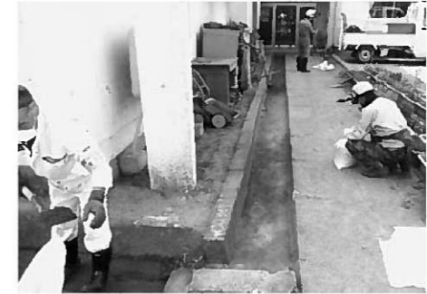
除染作業の様子
