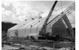
産廃処理場の大型テント
