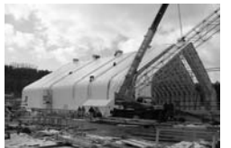
産廃処理場の大型テント
