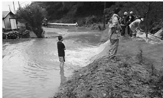
平成25年7月に発生した大雨被害
