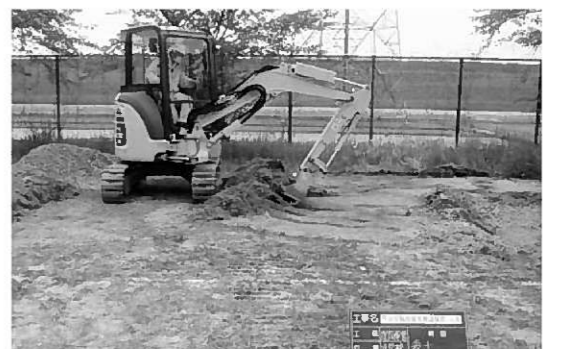
除染作業当時の様子
