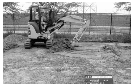
除染作業当時の様子
