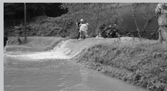
町道に越流した矢の尻川
