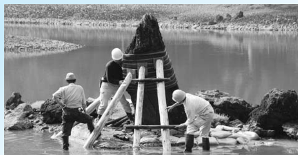
立石の転倒を防ぐために取り付けられた支柱
