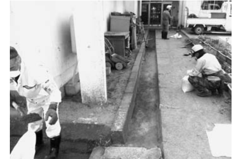
除染作業の様子
