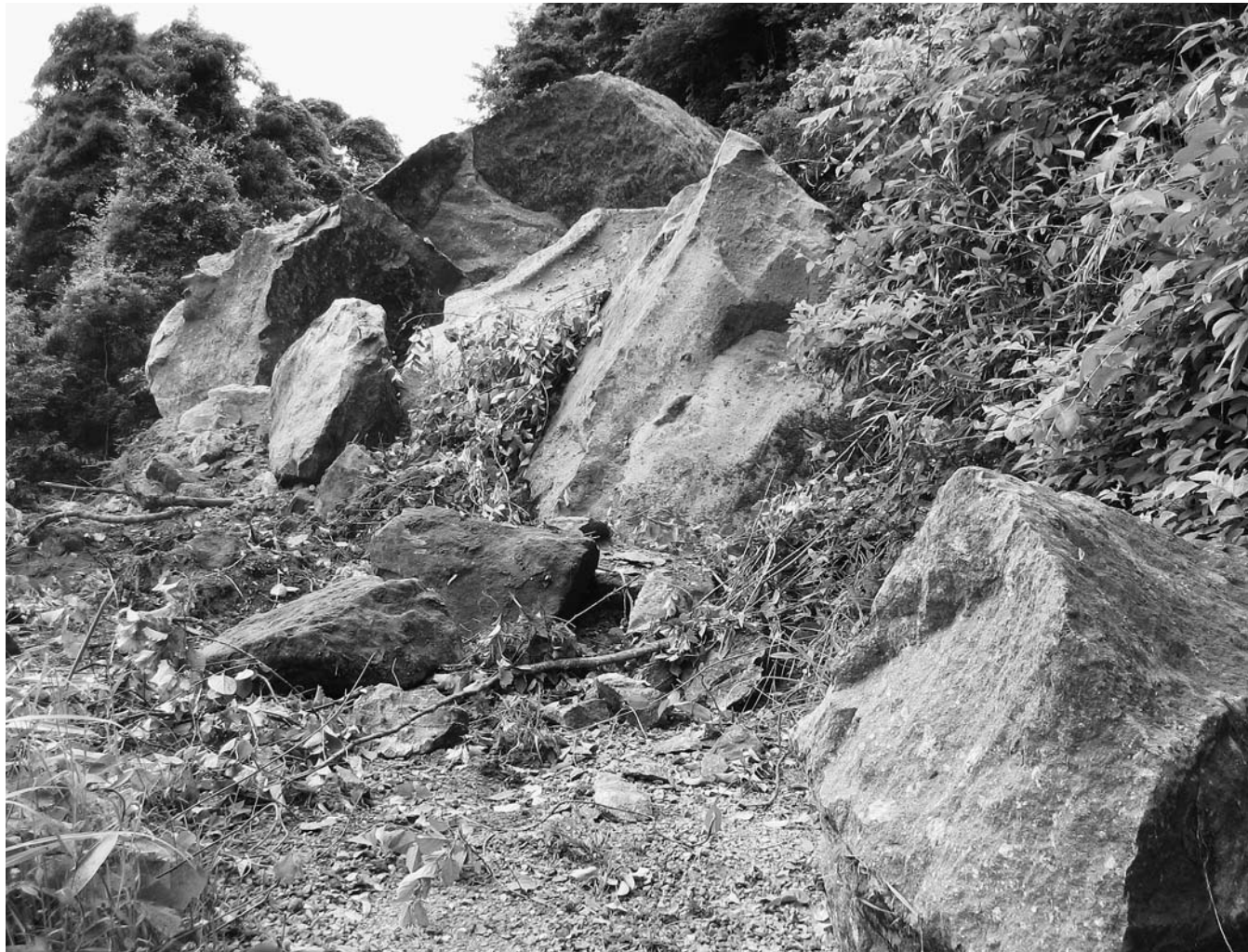
平成20年6月の岩手・宮城内陸地震により岩山が崩落し寸断された町道南郷線
