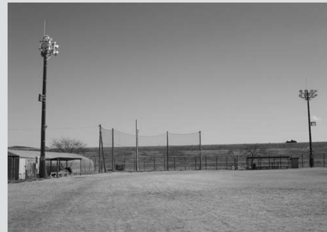
完成した平泉中校庭照明施設
