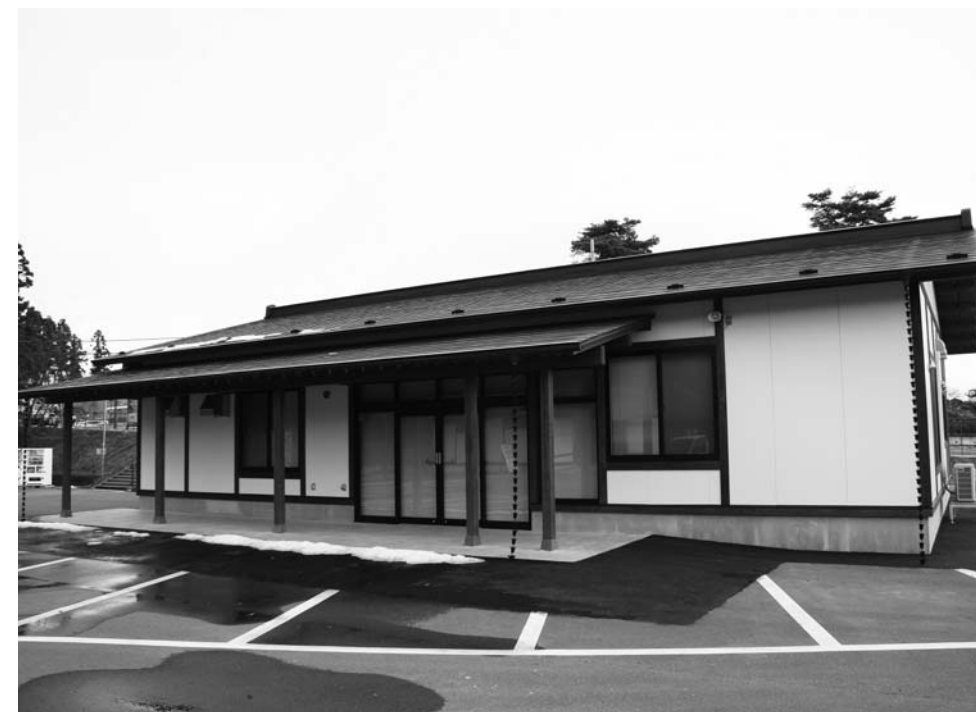
町営毛越寺駐車場内に建設された農産物加工直売施設。オープンは2月20日を予定
