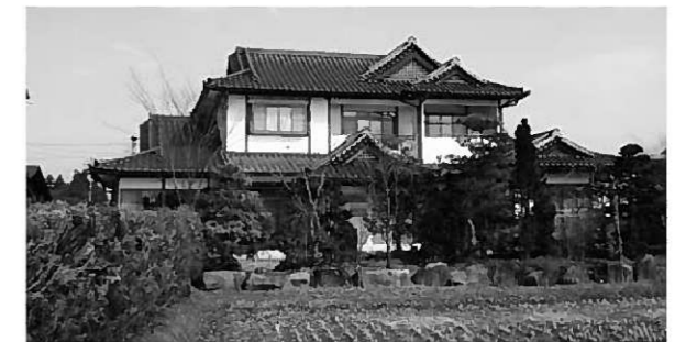
千葉さん宅(11区) 地域の伝統的在来民家を踏まえたもので、屋根、外壁に自然素材を使用し、非常に重厚に仕上がっている。 ▷設計者=高橋幸喜建築設計事務所(平泉町) ▷施工者=高橋工務株式会社(平泉町)
