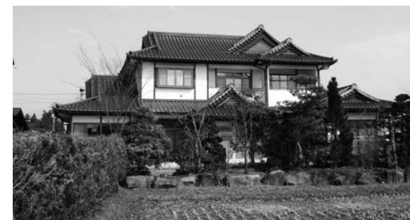
千葉さん宅(11区) 地域の伝統的在来民家を踏まえたもので、屋根、外壁に自然素材を使用し、非常に重厚に仕上がっている。 ▷設計者=高橋幸喜建築設計事務所(平泉町) ▷施工者=高橋工務株式会社(平泉町)
