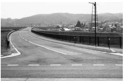
昨年3月に通行可能となった町道中学校線
