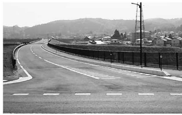
▲整備が完了し通行可能となった町道中学校線
