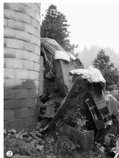
①高速道ボックス内の照明用引き込み電柱が倒れた②畜舎に隣接する壁が、岩手・宮城内陸地震に加えた被害を受け倒壊した。
