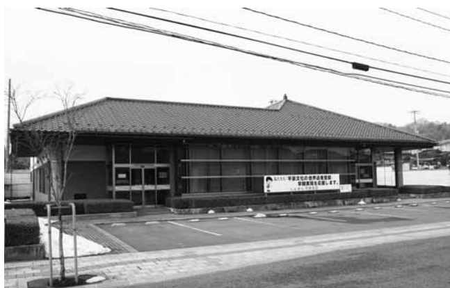
一関信用金庫平泉支店(11区)
